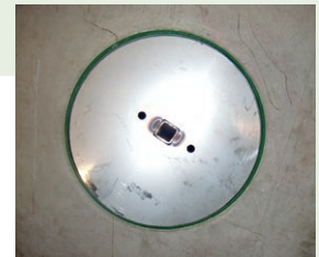
RVS bovendecksel in beton
